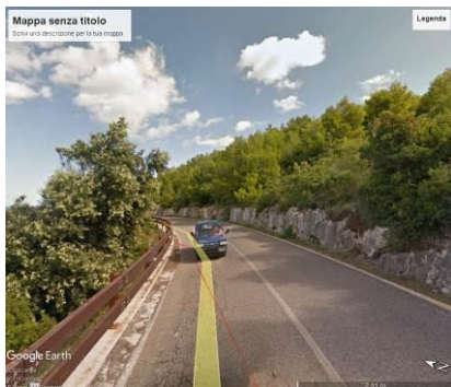
SS 89_ percorso attraverso Monte Pucci
