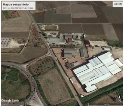
Dal casello Poggio Imperiale immissione sulle provinciali da mettere in sicurezza
