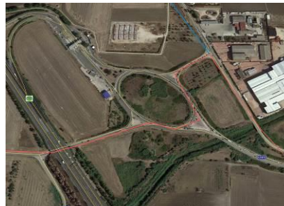
Punto critico nella zona della rotatoria nei pressi di Lesina
