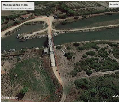
Secondo ponte su canale deflusso Lago di Lesina
