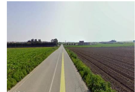
SP37 direzione Lesina (priva di banchina)
