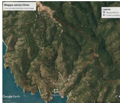
SP 53 arretrata rispetto alla linea di costa in corrispondenza di Pugnochiuso
