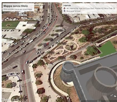
Manfredonia lungomare (Castello)- punto critico da mettere in sicurezza
