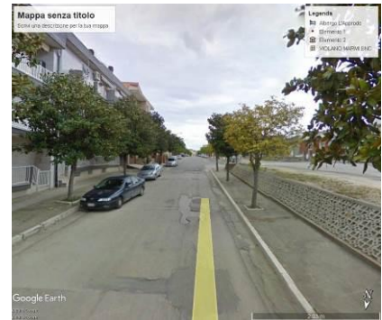
SP 37 entra e attraversa tutto il centro abitato di Poggio Imperiale
